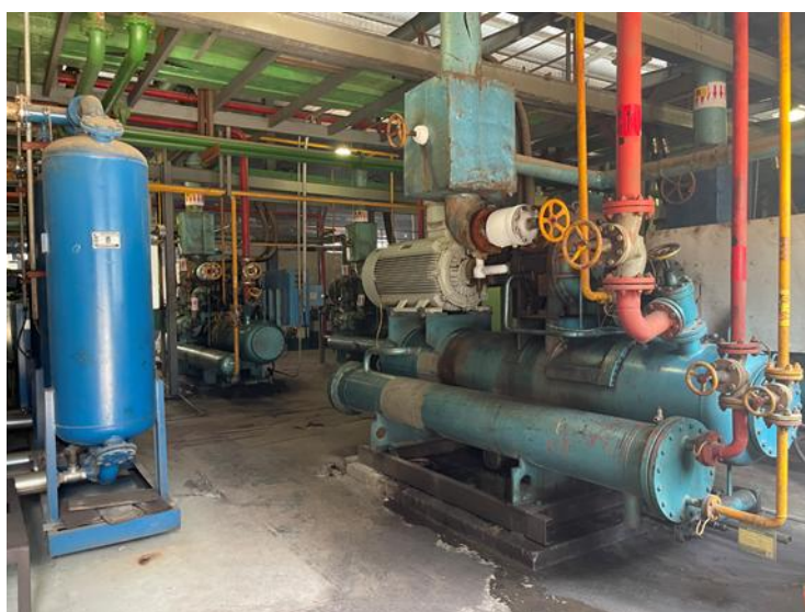
图3：氨制冷机房
