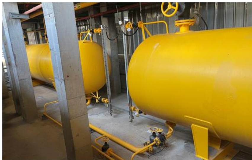
图2：重大危险源合成车间（制冰工段）贮氨器（10m³）2只
